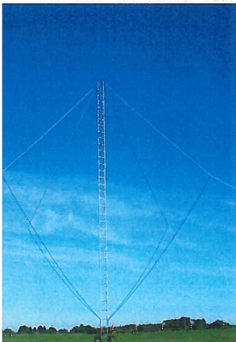
Figuur 3. De VLF antenne in Humain, met een 12 meter hoge mast.
